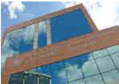
Hospital e Maternidade Guarulhos
